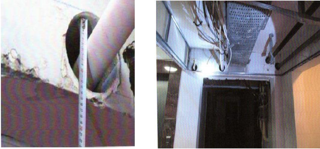
Şekil 7.7. Tarafımıza iletilen dökümanlarda görölen kirişlerde açılan delikler
